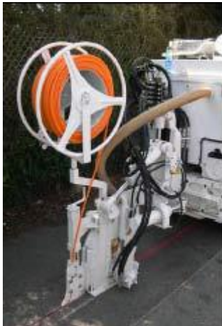
Csőfektetés aszfaltba mart mikroárkba
